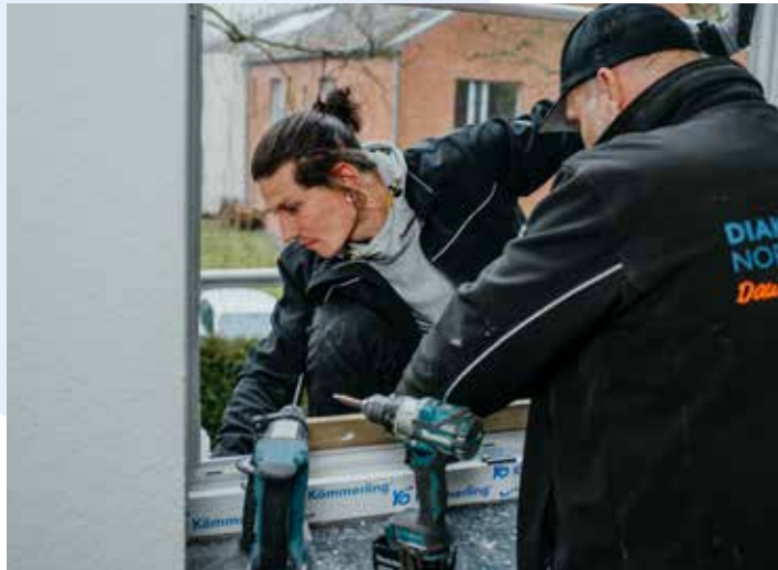
Teamwork: Linus Fricke setzt mit einem Kollegen ein Fenster ein.
