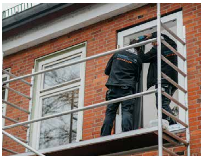
Gut gerüstet: Präzisionsarbeit von innen und außen.
