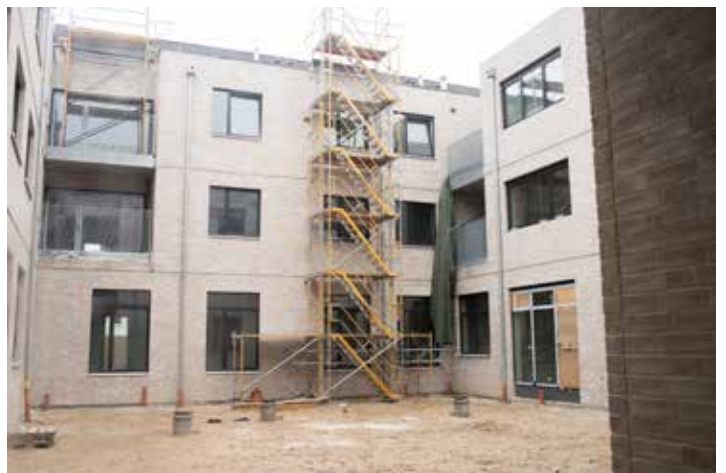
Noch steht das Baugerüst im Innenhof des neuen Klinikgebäudes.
